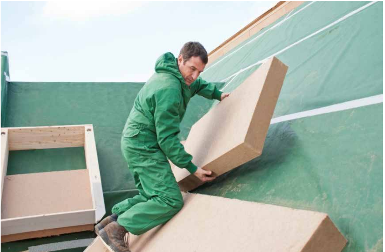
zateplenie strechy pomocou nadkrokovou doskou STEICO special dry
