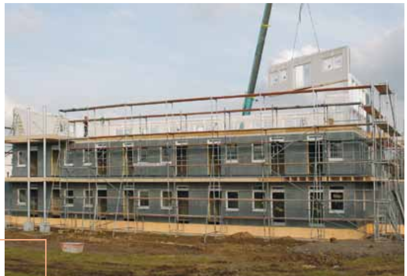
Vícepodlažní budova na bázi dřeva opláštěná sádrovláknitými deskami FERMACELL.
